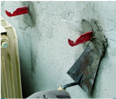
Montage von Heizungshalterungen mit Lampocem
