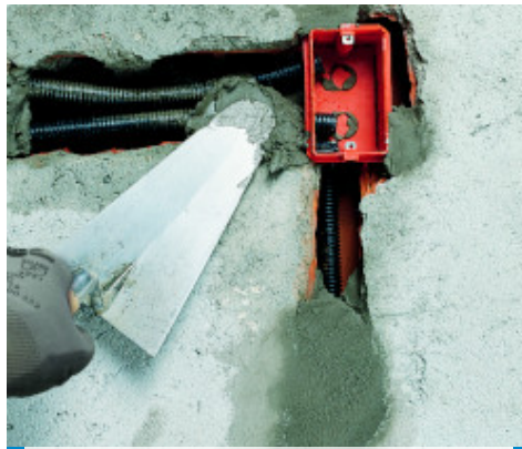
Montage von Elektroinstallationen mit Lampocem
