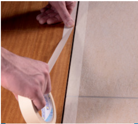
Abkleben der Fuge mit Kreppband
