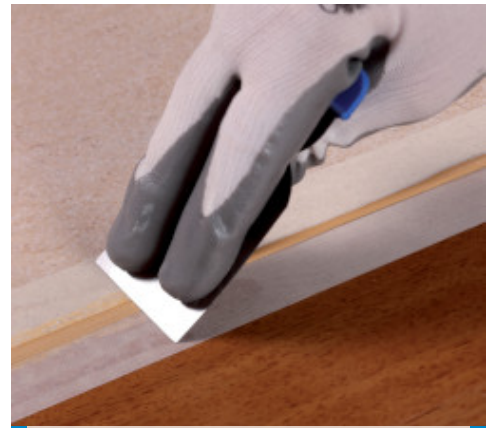
Glattstreichen der Fuge
