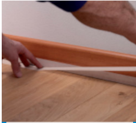
Abkleben der Fuge mit Kreppband
